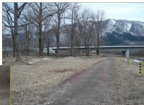
対象橋梁；PC4径間連続箱桁橋
