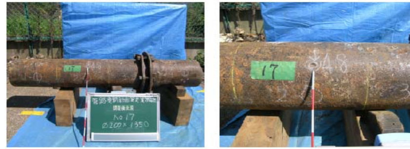
No.17 管体状況
